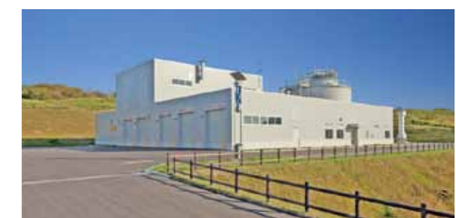
稚内市バイオエネルギーセンター
